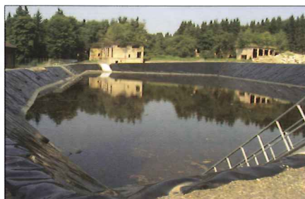
Links: Einmischen von Hochofenasche in den fast flüssigen Schlamm. Mitte: Das 2011 fertiggestellte Pufferbecken auf dem Werksgelände sammelt bei Starkregen das belastete Wasser. Im Hintergrund historische Werksgebäude. Rechts: Eins von heute noch etwa 70 existierenden Gebäuden auf dem Werksgelände: Stahlbetonskelettbau mit begrüntem Dach. Alle Fotos: J. Teicke
