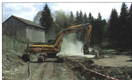
Links: Einmischen von Hochofenasche in den fast flüssigen Schlamm. Mitte: Das 2011 fertiggestellte Pufferbecken auf dem Werksgelände sammelt bei Starkregen das belastete Wasser. Im Hintergrund historische Werksgebäude. Rechts: Eins von heute noch etwa 70 existierenden Gebäuden auf dem Werksgelände: Stahlbetonskelettbau mit begrüntem Dach. Alle Fotos: J. Teicke
