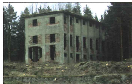
Links: Einmischen von Hochofenasche in den fast flüssigen Schlamm. Mitte: Das 2011 fertiggestellte Pufferbecken auf dem Werksgelände sammelt bei Starkregen das belastete Wasser. Im Hintergrund historische Werksgebäude. Rechts: Eins von heute noch etwa 70 existierenden Gebäuden auf dem Werksgelände: Stahlbetonskelettbau mit begrüntem Dach. Alle Fotos: J. Teicke
